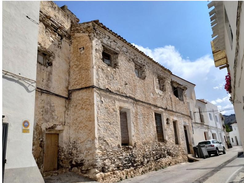
La edificación que se pretende demoler es sensiblemente rectangular, con una fachada a calle Bacares de unos 17,5 metros aprox. y a la Plaza de los Remedios de unos 7,9 metros. El resto del perímetro de la edificación forma medianeras tanto con la Ermita, como con el Convento. Consta de dos plantas de altura. Está construida con muros de carga de mampostería y con cubierta de teja árabe a dos aguas y una pequeña azotea, anexa a la Ermita.
